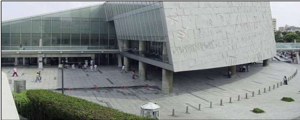
صورة رقم (١): الحوائط الخرسانية والزجاج المقاوم للحرائق والرصاص بمكتبة الإسكندرية
